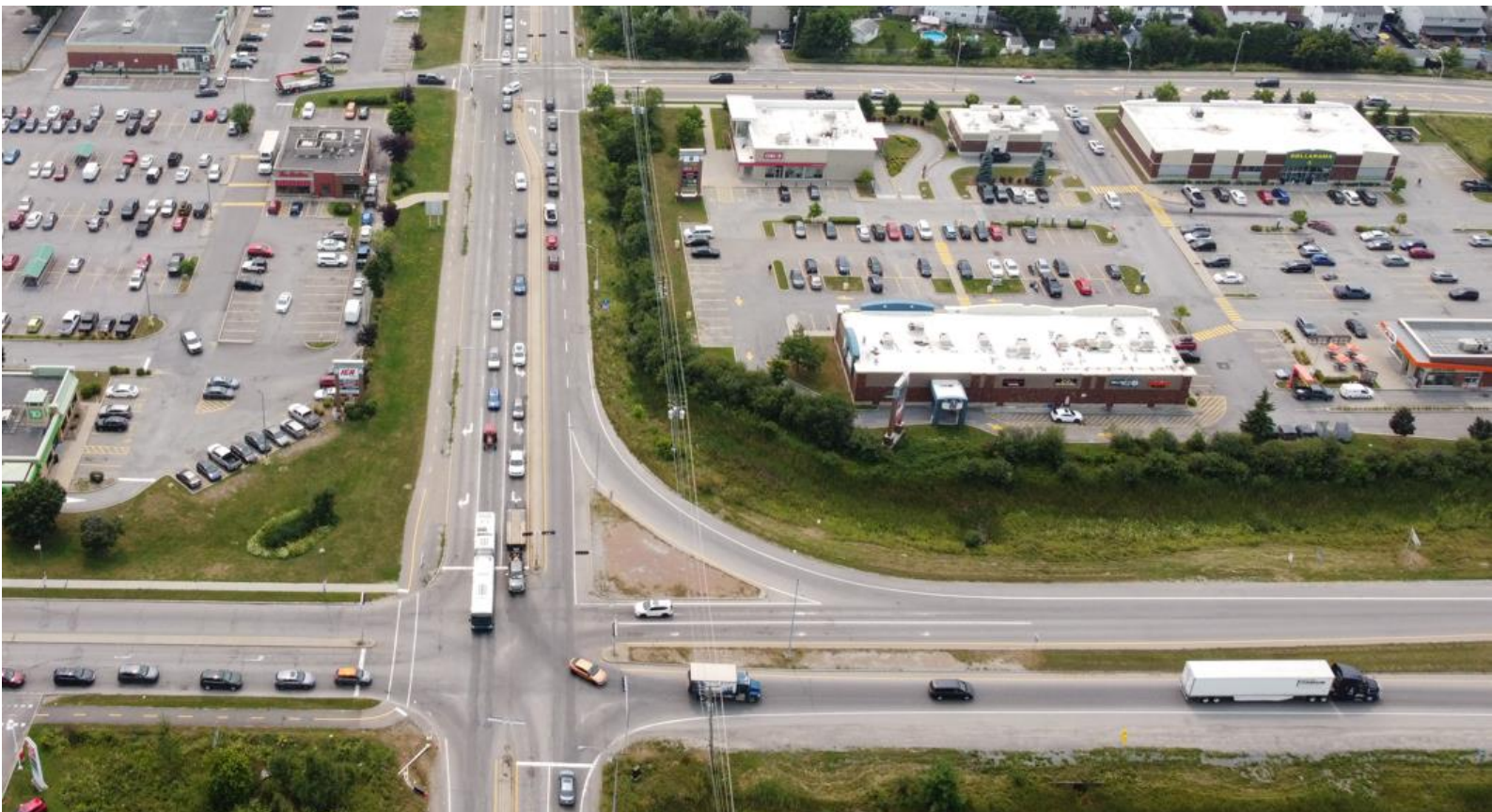
Vue vers le sud sur la montée Paiement, près de la rue Davidson et de l’accès à l’autoroute 50, à Gatineau Source: Adham Badran
