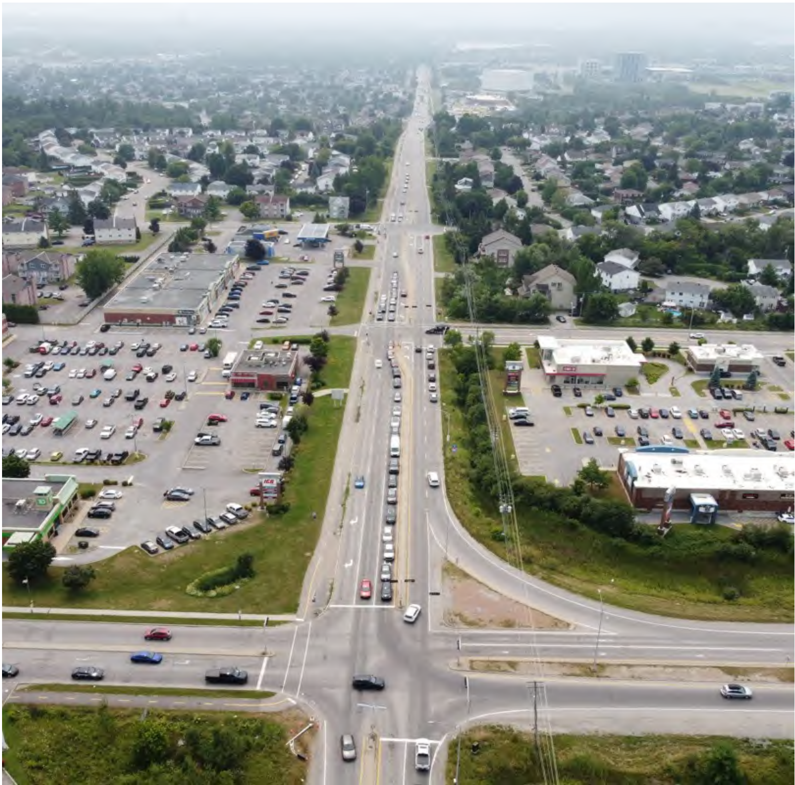
Corridor de la montée Paiement, vue vers le sud depuis l'échangeur de l'autoroute 50, Gatineau Source: Adham Badran
