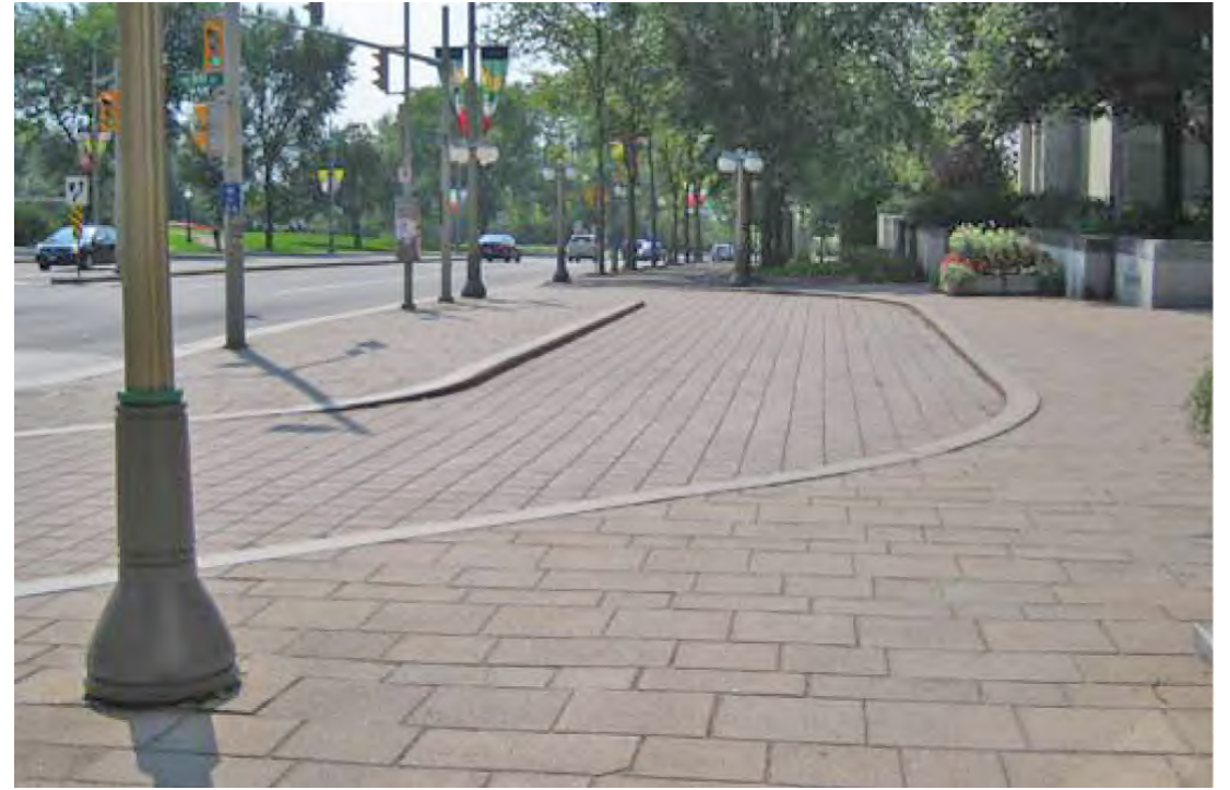
Figure 44 : Exemple de changement du motif pour marquer une voie accessible aux véhicules
