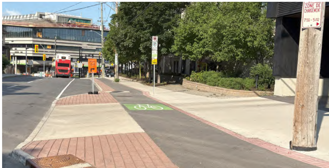
Figure 47 : Trottoir et piste cyclable continus qui traversent une entrée charretière, avec une rampe dont la largeur se limite à celle de la banquette et rayon de virage réduit au minimum
