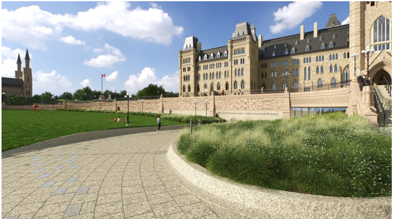
Chemin en pente menant à la nouvelle entrée du Centre d'accueil du Parlement; le motif de pavage est réalisé avec des pavés en granit de Stanstead en deux finis (sablé et adouci).
