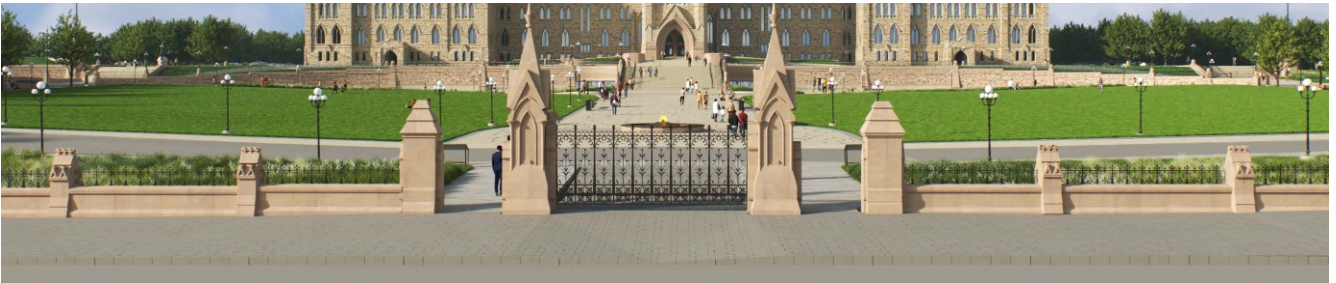
Bordure de la rue Wellington. Amélioration de l'accès piétonnier à la porte de la Reine grâce à des sentiers en pente douce.
