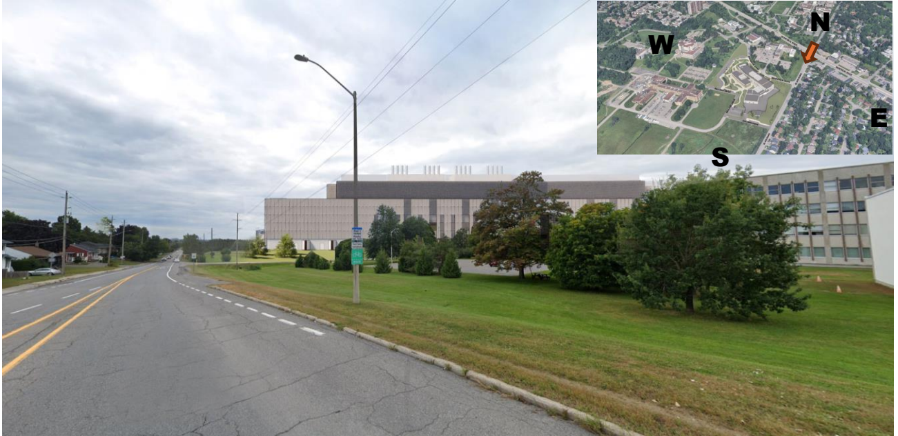
Barre de laboratoires – Façade nord avec entrée du personnel
