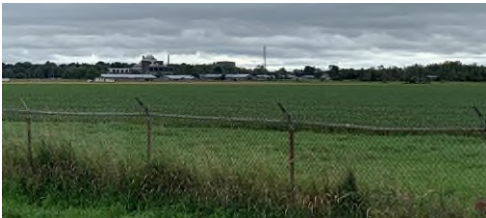
Image : Vue du site du projet Principal SRSS depuis le chemin Greenbank, en direction sud.
