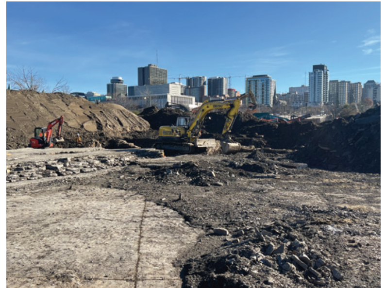
Travaux d'assainissement de l'île Victoria
